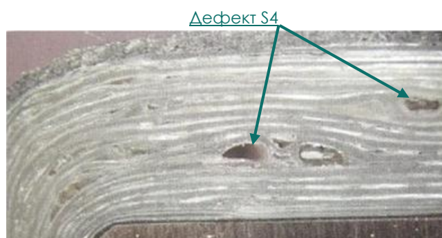
Дефект S4 – микрополости внутри основной изоляции обмотки статора
